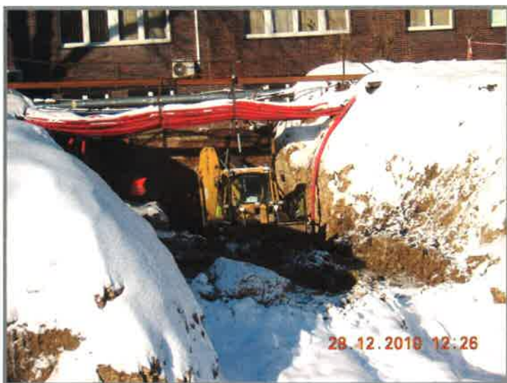
Foto – Zemní práce na spojovací chodbě
