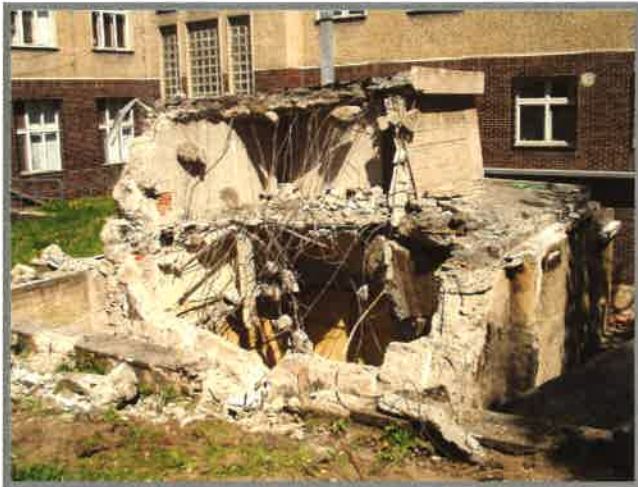
* Foto – demolice staré ozařovny
