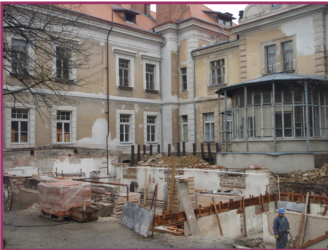
Foto – Stavební práce na rekonstrukci NP
