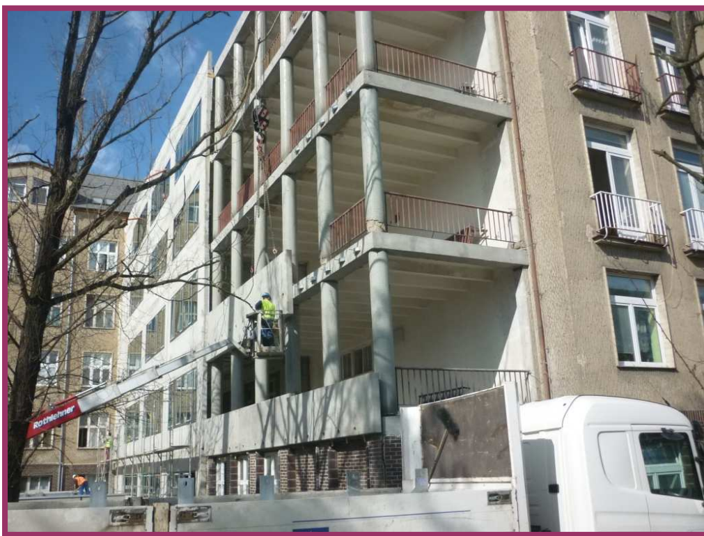
Foto – Nová spojovací chodba podél bloku B
