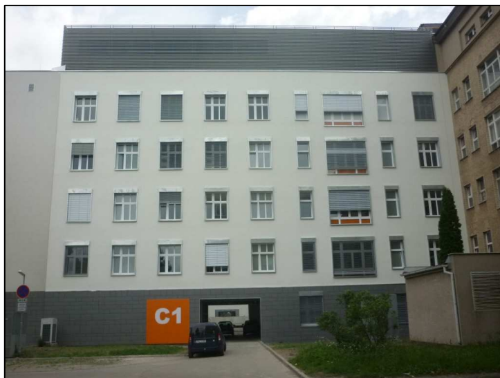
Foto – Pohled na blok C1 od západu
