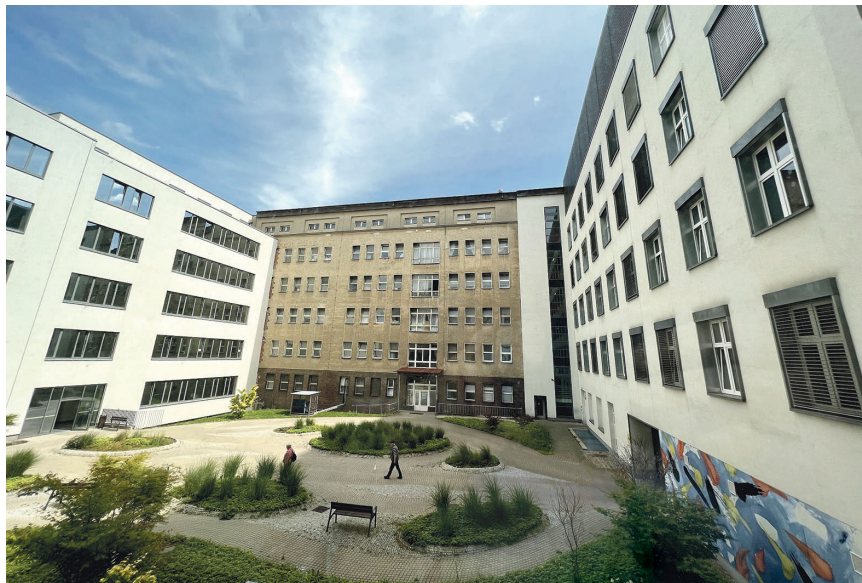
Rekonstrukce bloku C2 je tak dalším logickým krokem v modernizaci monobloku celé nemocnice a navazuje na již zrenovované objekty C1 a B a novostavbu budovy Centra akutní medicíny (CAM)
